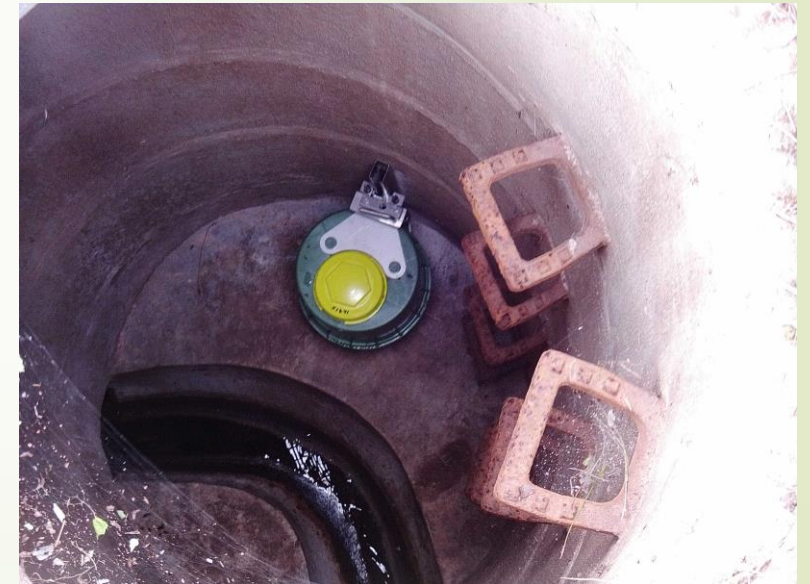
Installation von Rattenfallen
