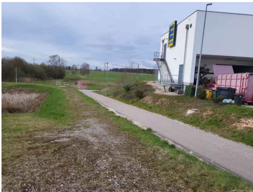
Bestehender Geh- und Radweg zwischen RRB und Einzelhandel
